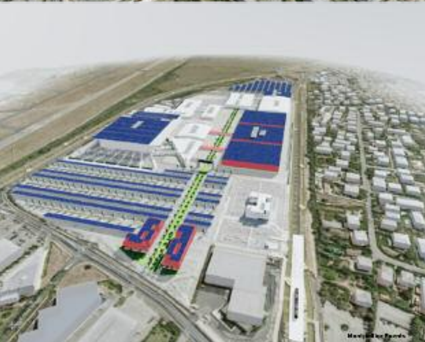
Le site aujourd'hui puis à l'issue des travaux.
